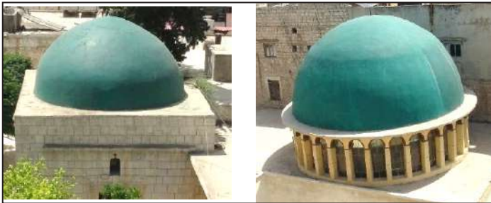
الصورة (18): قبة الحرم. الصورة (19): قبة المدفن.
